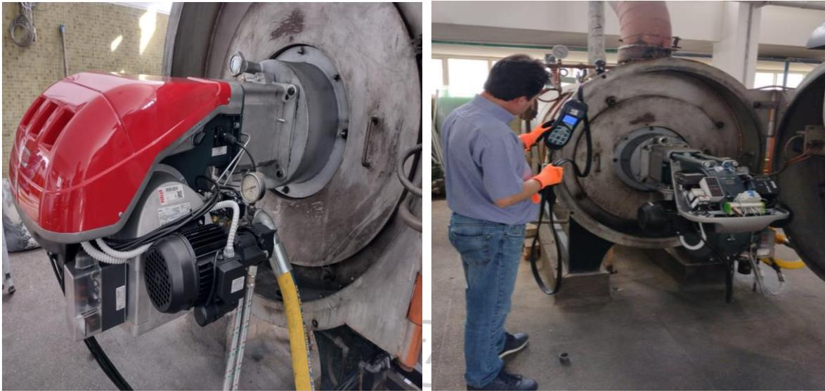
Al presentar tiempos de funcionamiento más prolongados e incremento en los procedimientos quirúrgicos, la institución realizó la adquisición de quemadores industriales de gran capacidad (60BHP) con el fin de actualizar el sistema y lograr un ahorro del gas natural, de tal manera que se maximice su rendimiento y se optimicen costos.
